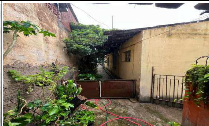
Acesso Corredor Lateral - Fundos
